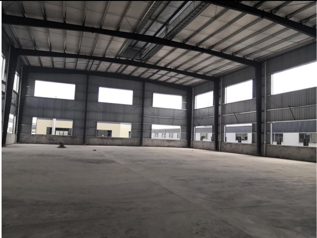
图 2-8 项目厂房内部现状图
